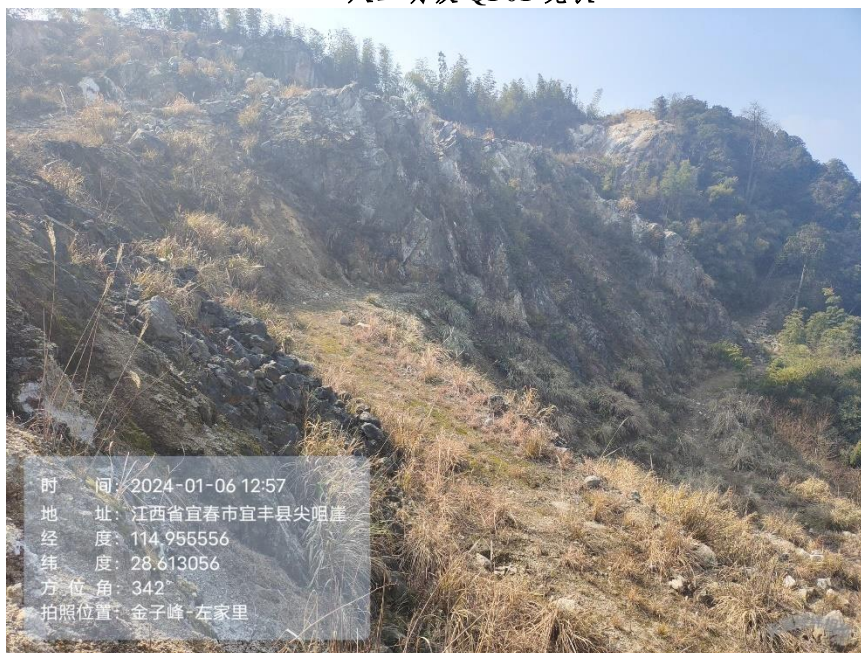
人工切坡 QP02 现状
