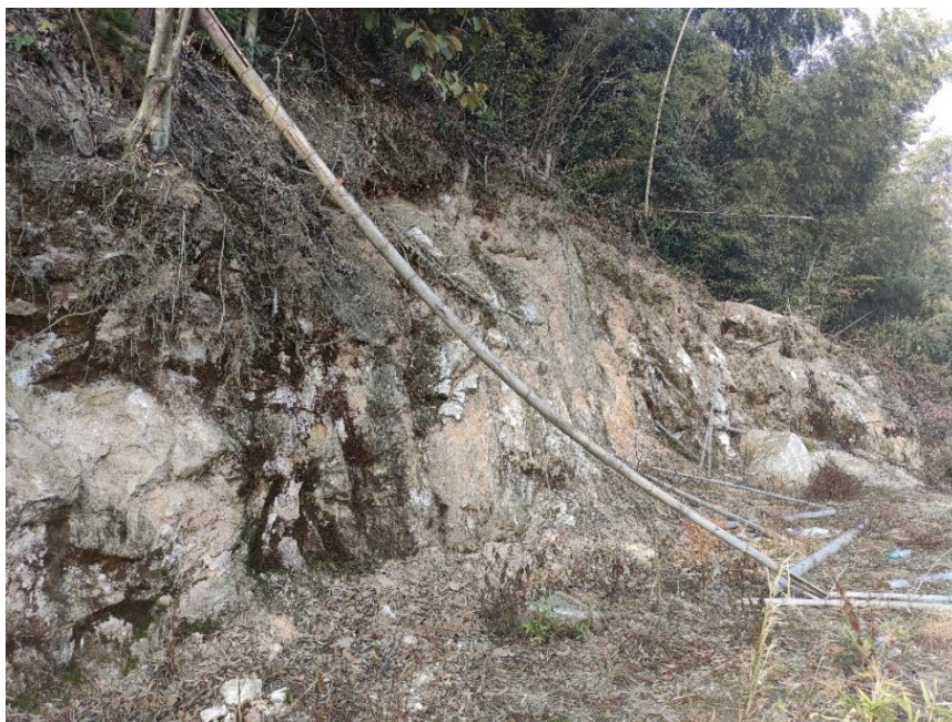
人工切坡 QP01 现状
