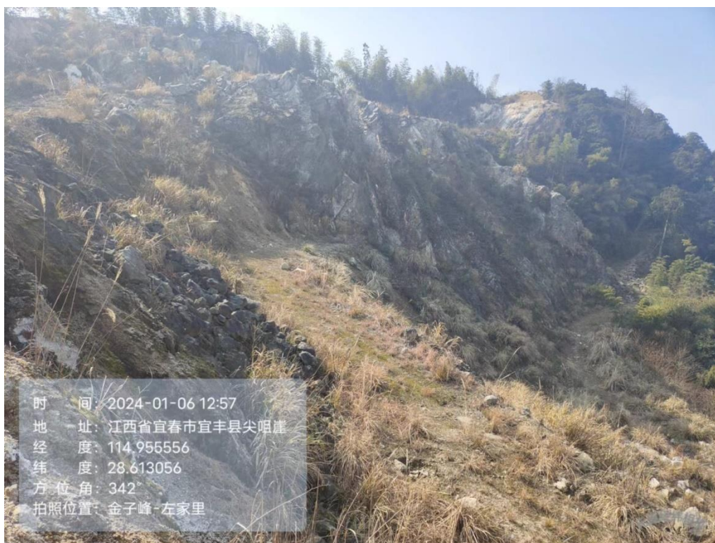
图 1-4 金子峰硅石矿 Ka-1 采坑现状
